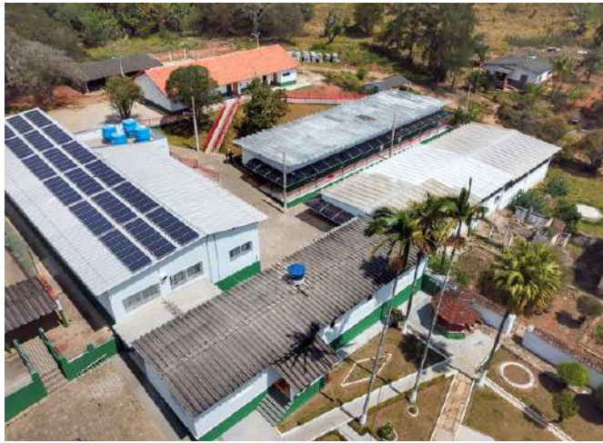
Figure 7: Campus Carmo de Minas Alameda Murilo Eugênio Rubião, s/nº - Bairro Chacrinha - CEP 37.472-000 - Carmo de Minas - MG
