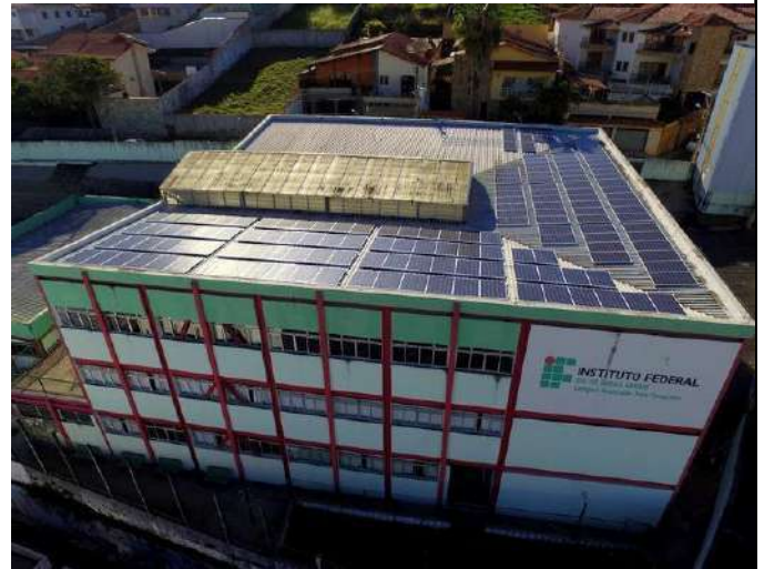
Figure 8: Campus Três Corações solar power plant.
